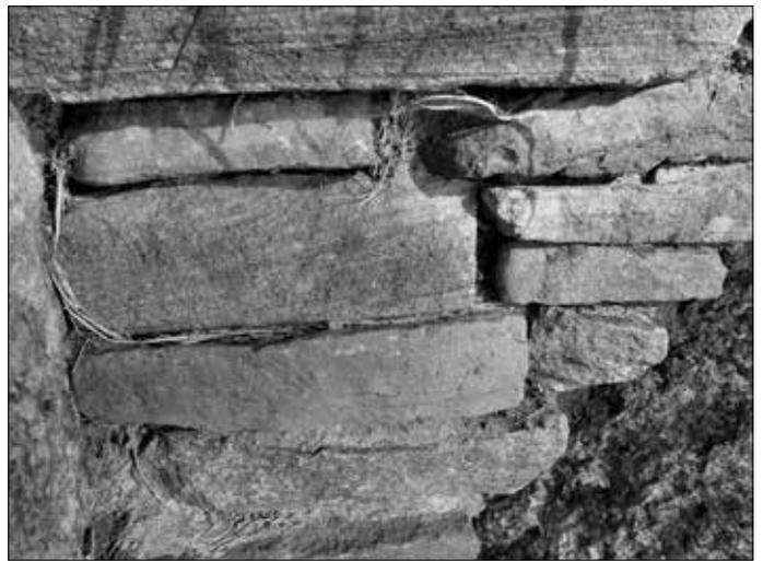
*Bilder 11 und 12: Zwischen den Findlingen wurde der Erdhügel durch Trockenmauern abgestützt.*
